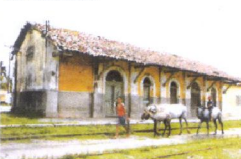
Estação Ferroviária - Murici - AL
